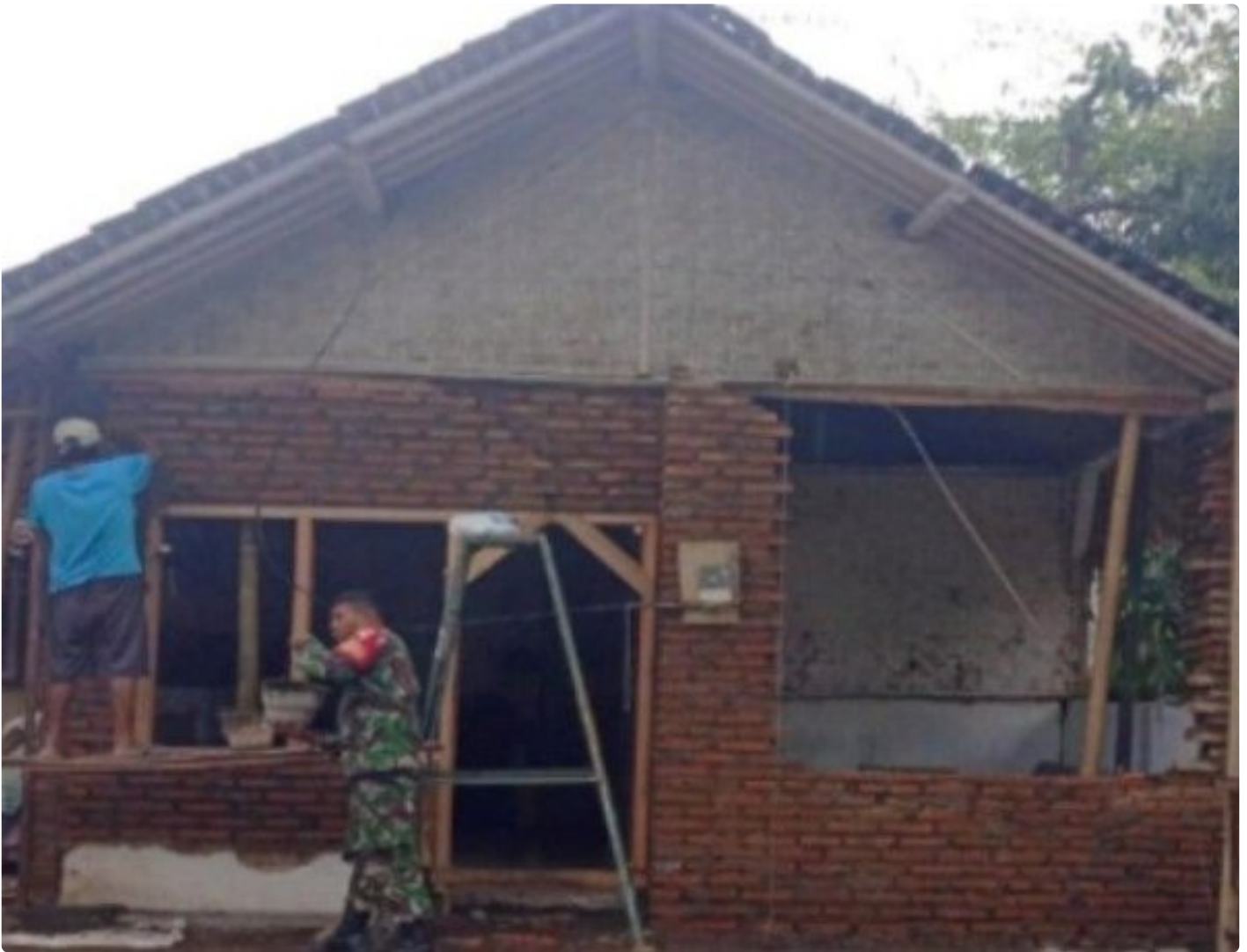
JEMBER - Kegiatan Pengerjaan renovasi rumah tidak layak huni (Rutilahu)
